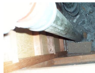
パイプシャフト内
