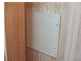
洗面横点検口
